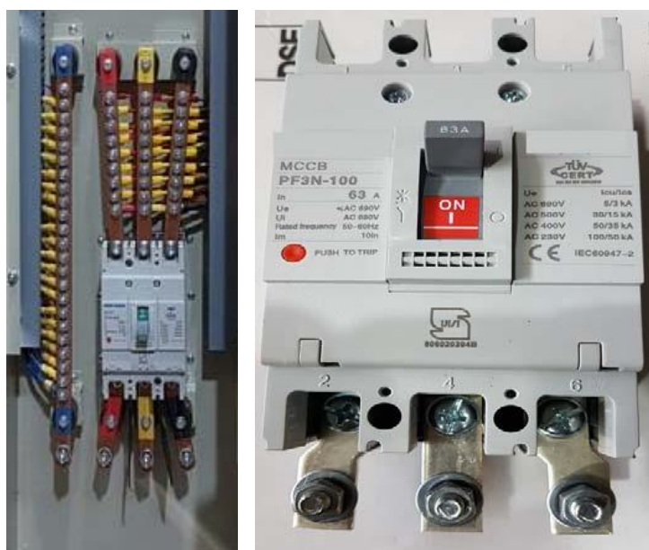
شکل ۳: الف) شینه‌های فابریک ب) شینه‌های کمکی کلید اتوماتیک
