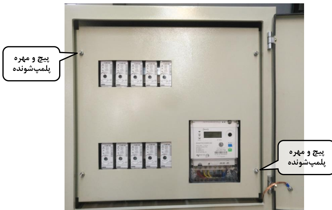
شکل ۷: روبند کنتورها
