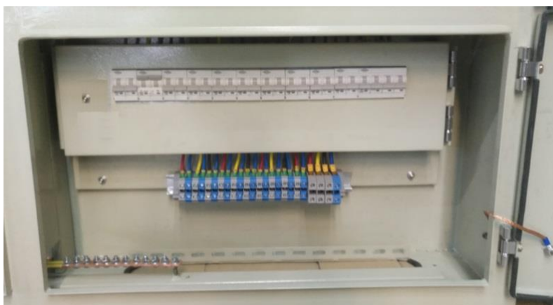
شکل ۵: روبند کلیدفیوزهای مینیاتوری خروجی
