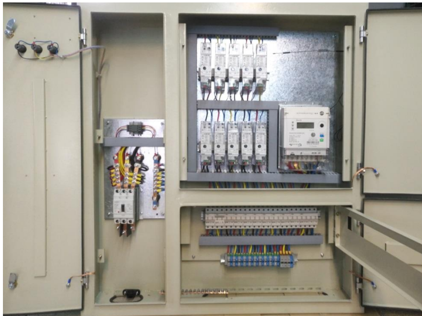
شکل ۴: صفحات نصب تجهیزات
